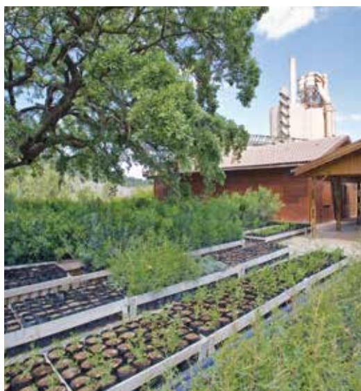
/ Estufas da Fábrica Secil-Outão
